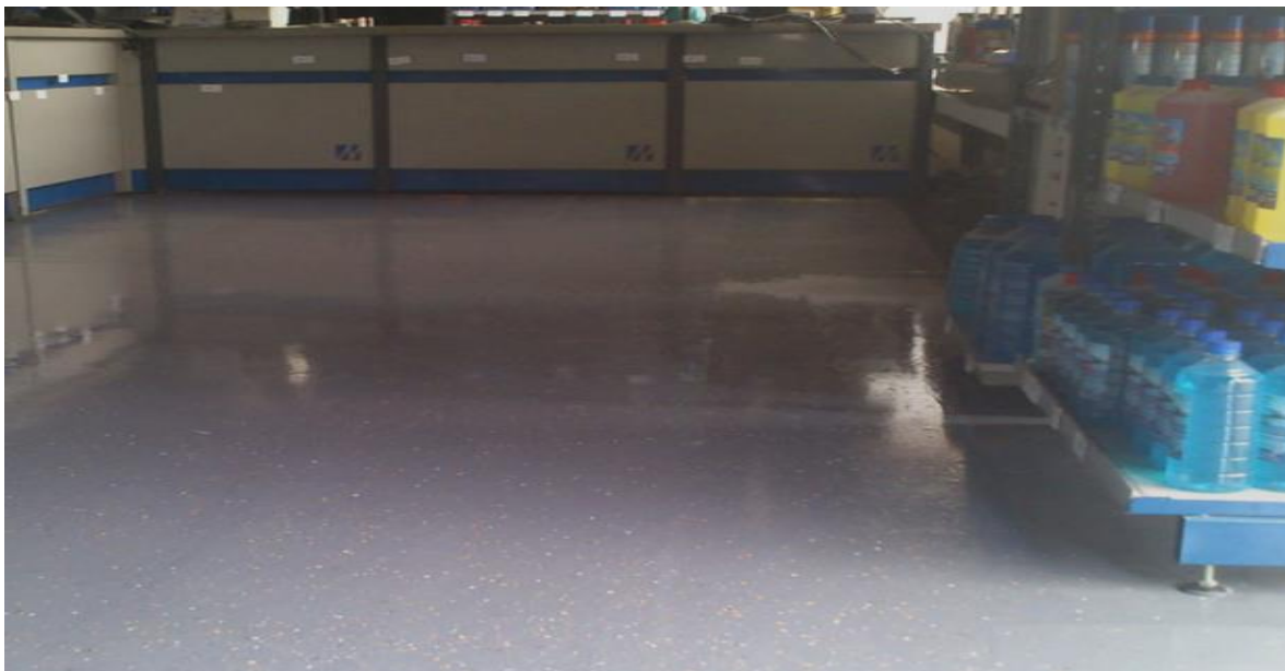
Slika 2. Podna obloga sa epoksidnim premazom i posipom.
