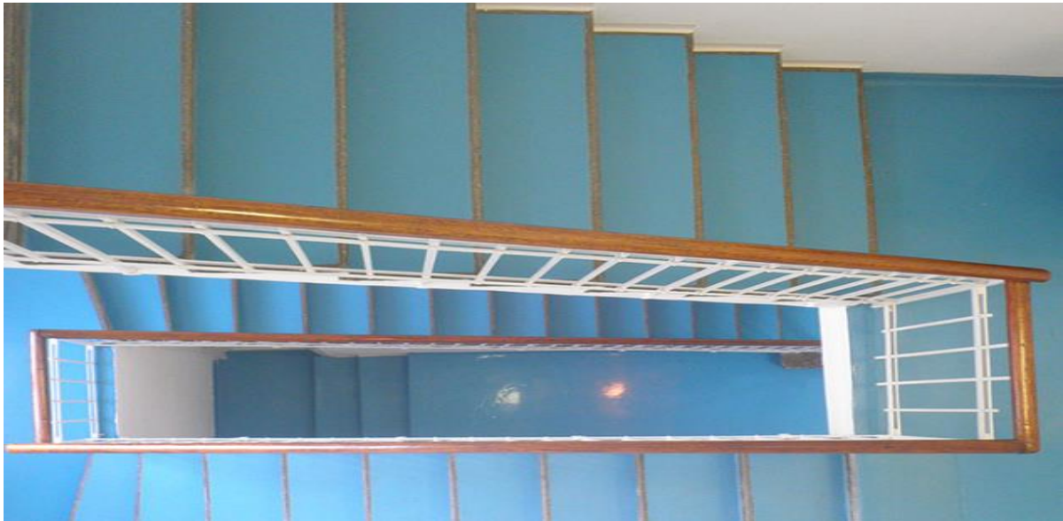
Slika 6. Poliuretanski premaz s granulama gume.
