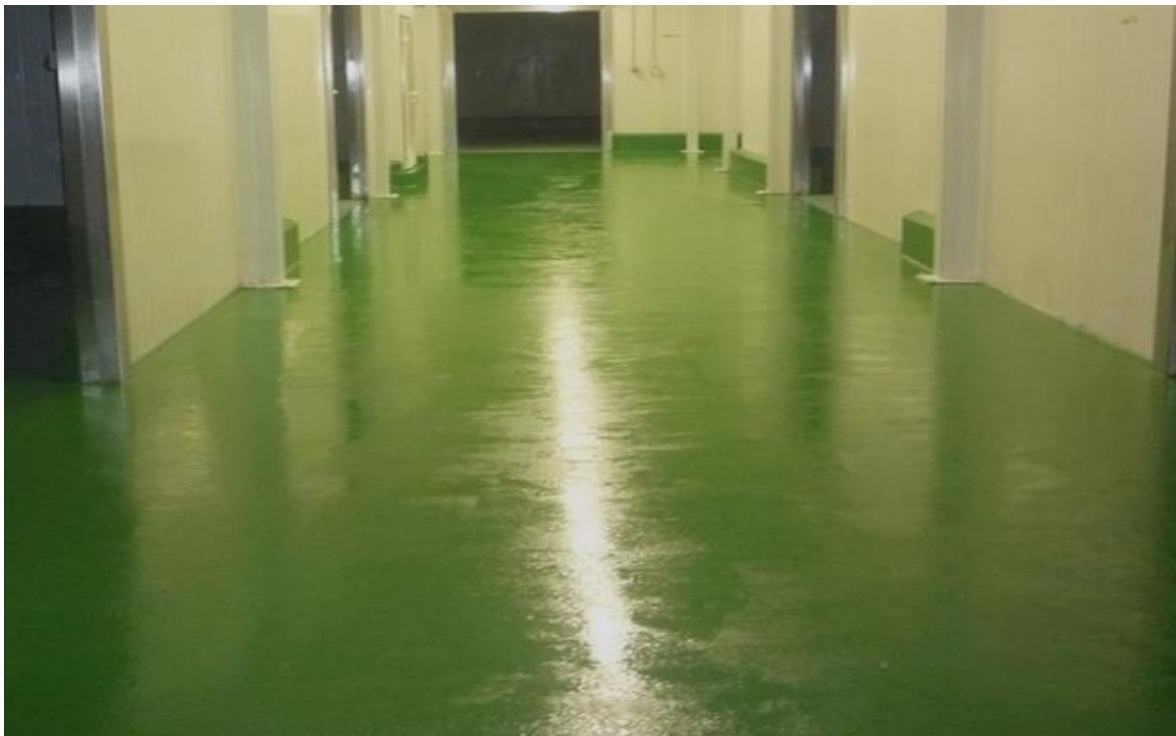
Slika 5. Epoksidni premaz zasićen kvarcnim pijeskom.
