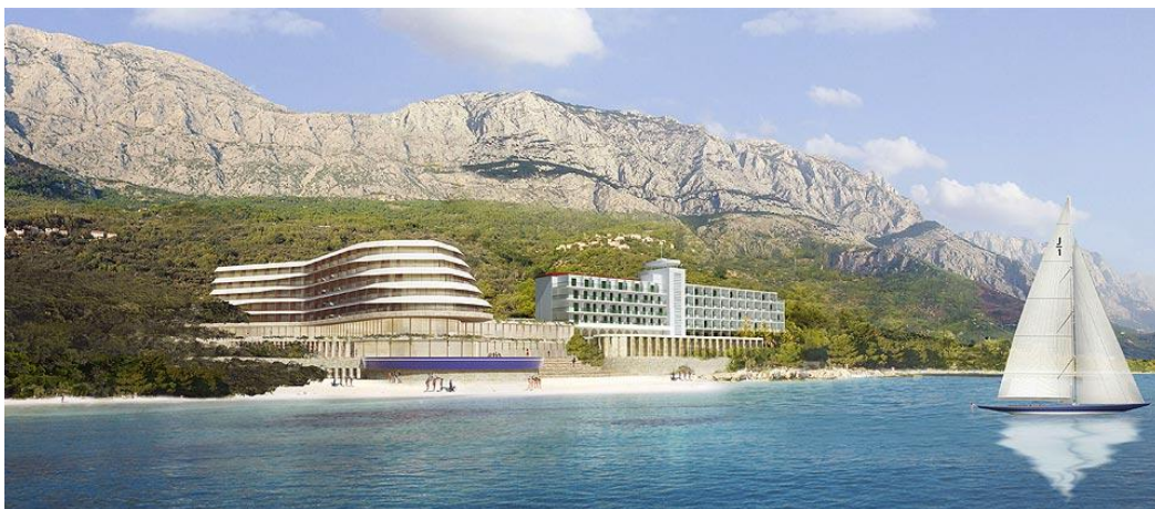
Slika 2. Hotel Jadran u Tučepima nakon renovacije
