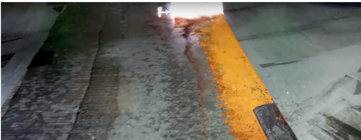
Slika 26. Prikaz površine nakon laserske obrade skidanja korozije
