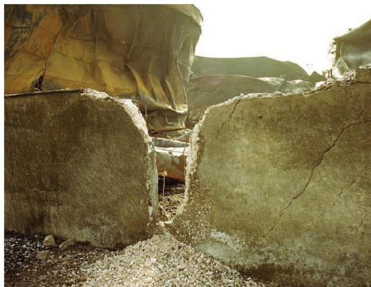
**Slika 23:** Spojno mjesto zida sabirnog prostora nakon ugašenog požara [7].
