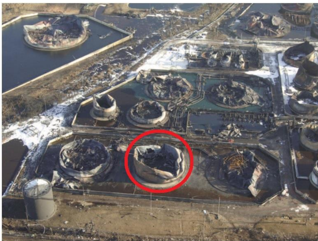
Slika 17: Izgled poharanog naftnog terminala nakon ugašenog požara ( spremnik 912 , iz kojega su se izlile znatne količine benzina iz čijih se para zatim formirao oblak zapaljive i eksplozivne smjese, označen je kružnicom crvene boje) [7].
