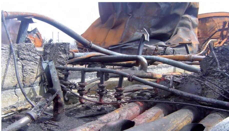
**Slika 24:** Prikaz mesta razaranja zida sabirnog prostora zbog termičkog rastezanja cijevi pod utjecajem visokih temperatura u požaru [6].
