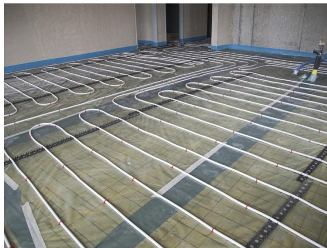
Slika 5: Paneli (ogrjevne površine)
