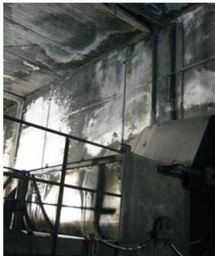
Slika 6. Miješalica i okolni zid i strop [11].
