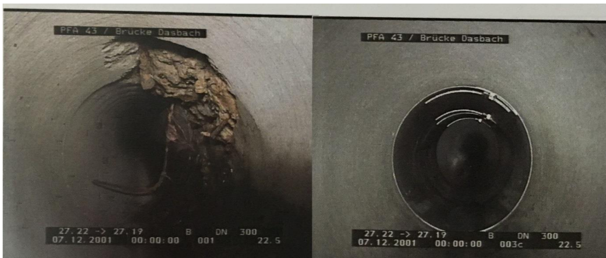
SI. 3. Postupak popravka: Sustavi naglavka [4]
