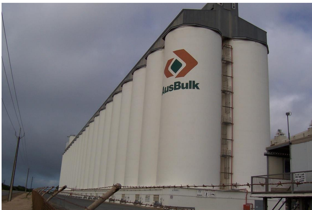
Sl.7. Betonski silos sa 42 komore silosa [8]
