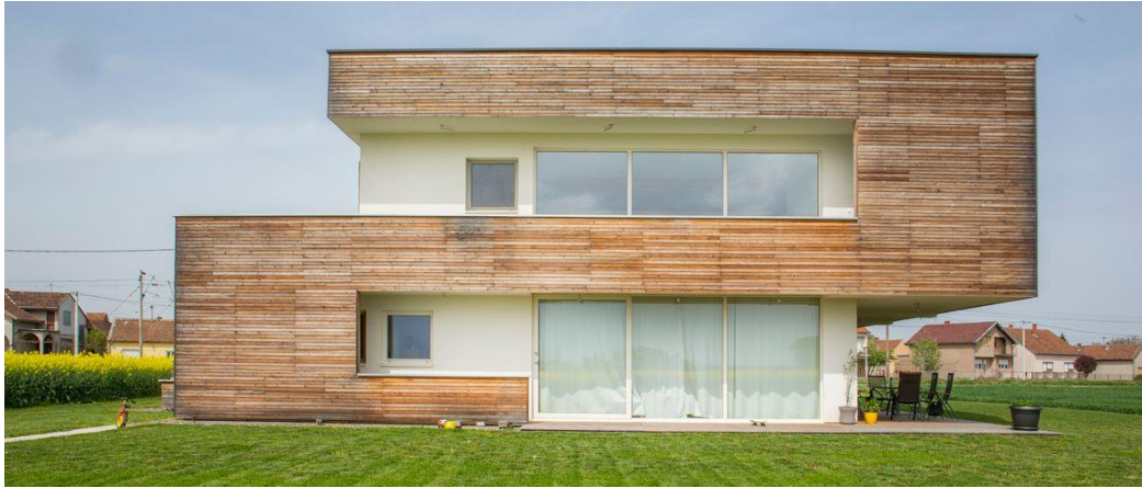
Sl. 2. Prva moderna kuća od slame, Vinkovci [1]
