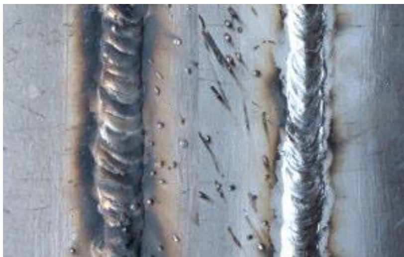
Slika 15. Kod lijevog zavara smjer zavarivanja pogrešan (zavar crn)
