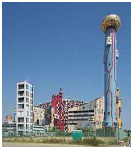
Slika 7. Spalionica otpada Maishima (Osaka, Japan)[9]
