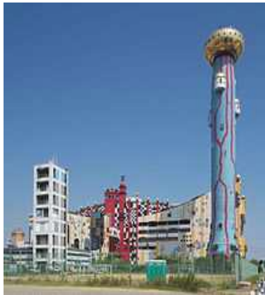
Slika 7. Spalionica otpada Maishima (Osaka, Japan)[9]
