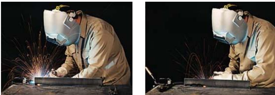
Slika 23. Prskanje rastaljenog metala kod MIG/MAG i STT postupka zavarivanja [8]
