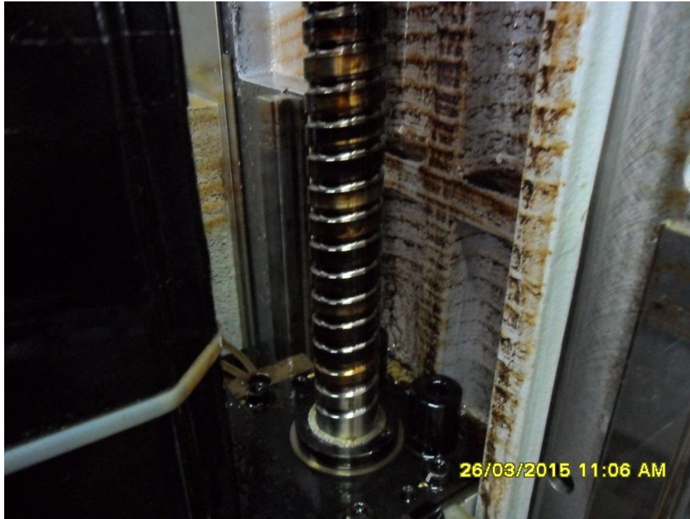
Slika 22: Oštećeno kuglično navojno vreteno
