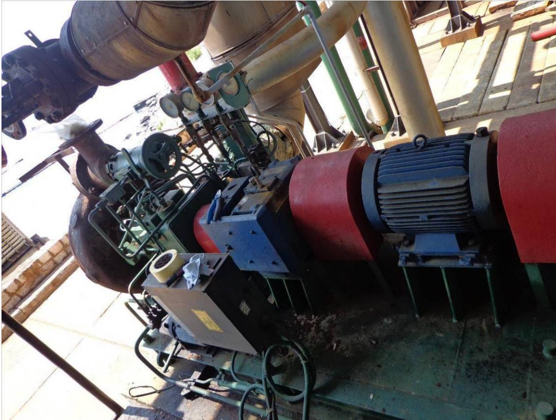
Fotografija 3.1 Stanje turboagregata prije demontaže
