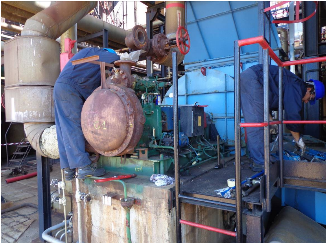
Fotografija 3.4 Demontaža turboagregata
