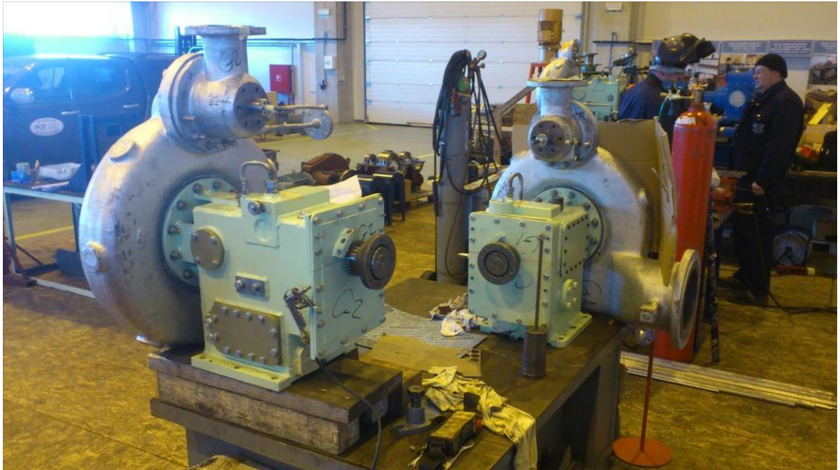
Fotografija 4.3 Podmontaža turbine
