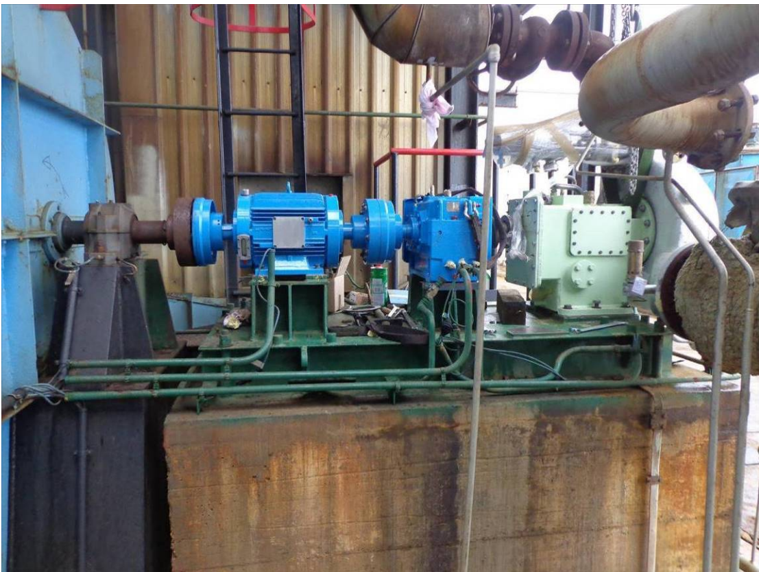
Fotografija 6.2 Montaža turbine
