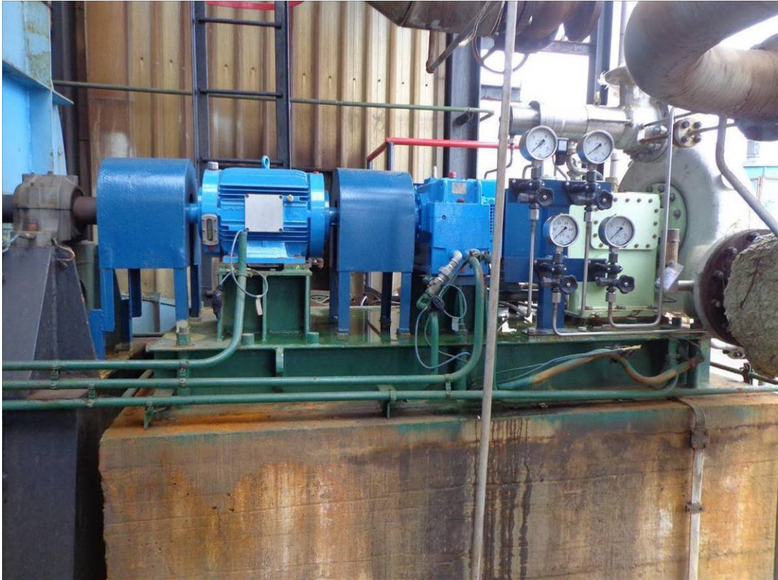
Fotografija 6.5 Montaža lokalne instrumentacije
