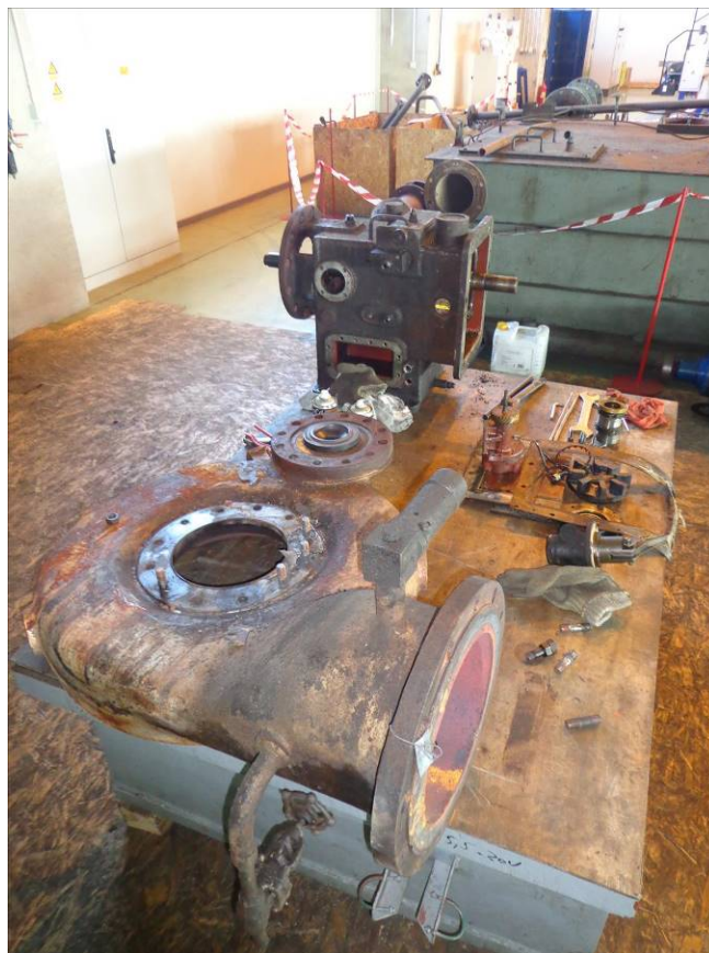
Fotografija 4.2 Defektaža kućišta turbine, SLB-a i GUP-e
