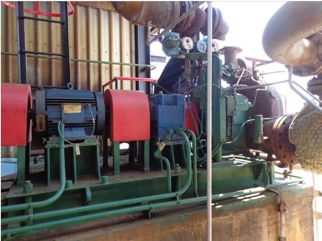
Fotografija 3.3 Stanje turboagregata prije demontaže
