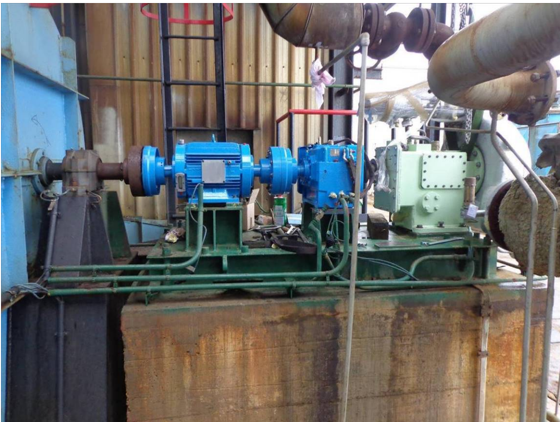
Fotografija 6.2 Montaža turbine
