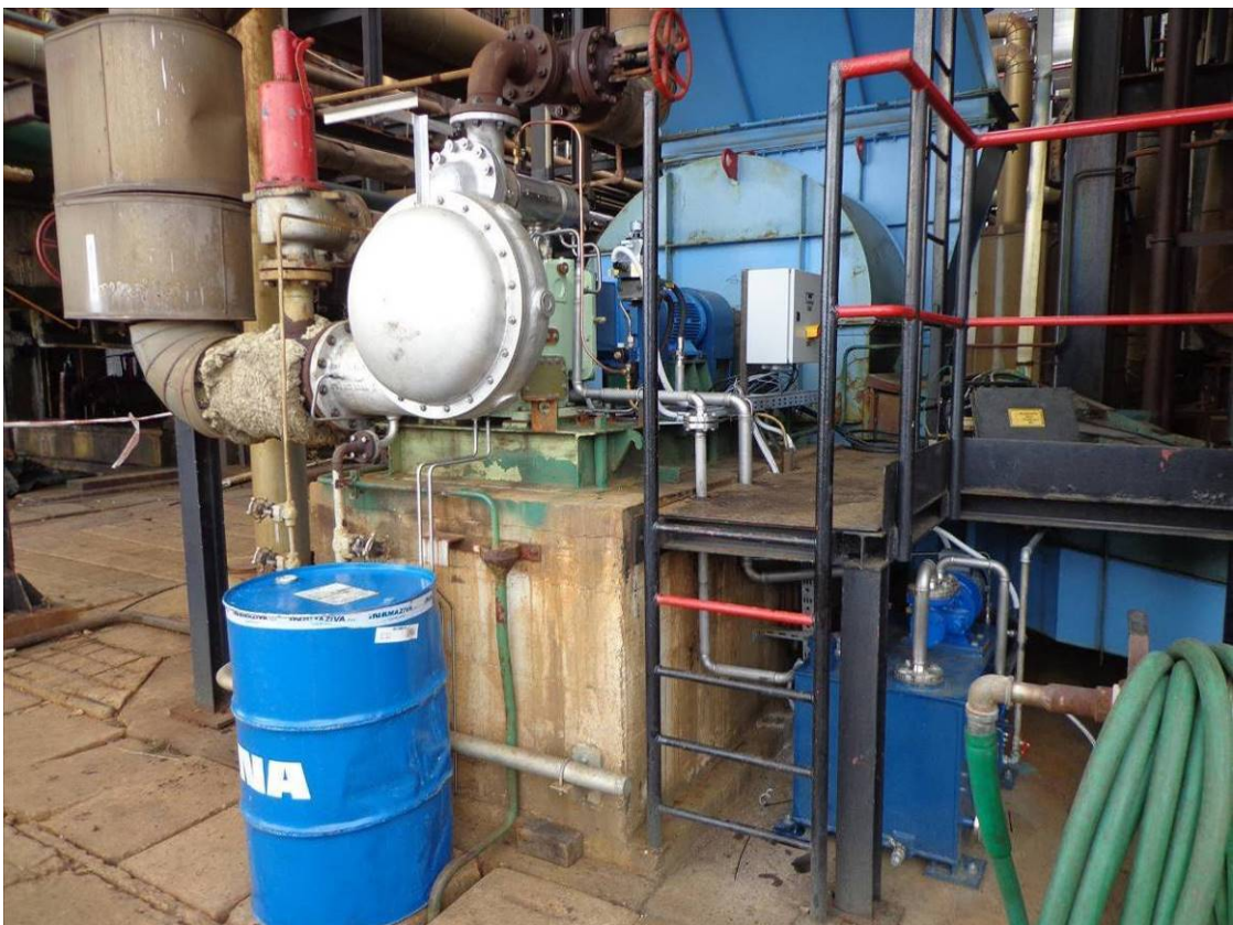
Fotografija 6.6 Montaža E/H pretvarača, punjenje uljnog spremnika
