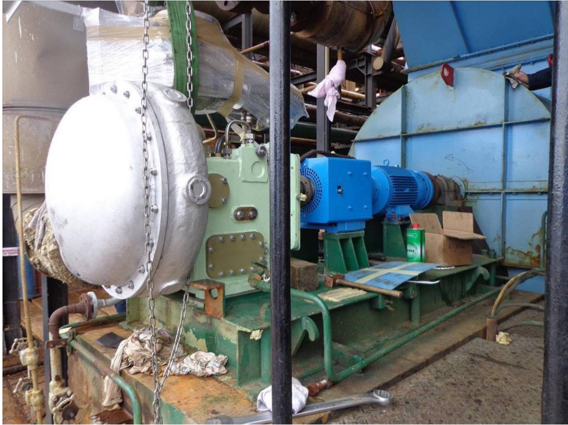
Fotografija 6.3 Montaža turboagregata
