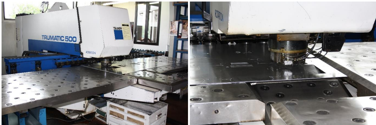
Slika 28 Izrezivanje lima za kućište i probijanje rupa
