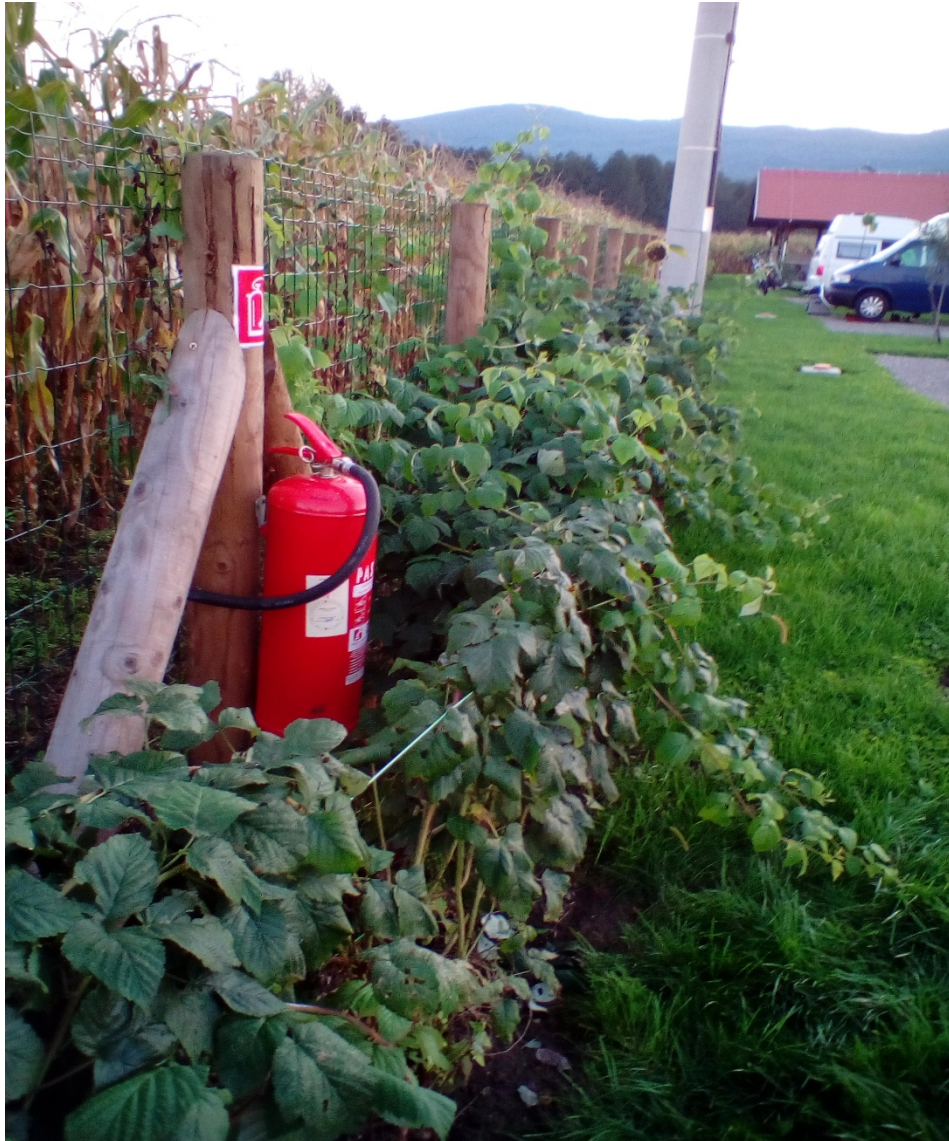
Slika 19: Vatrogasni aparat sa prahom postavljen za zaštitu sadržaja kamp prikolica [14]
