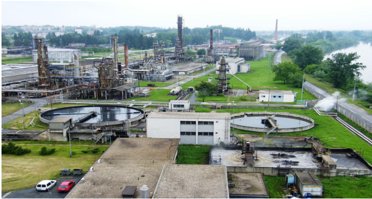
Slika 17 - Centralni uređaj za obradu otpadnih voda OV-4[2]
