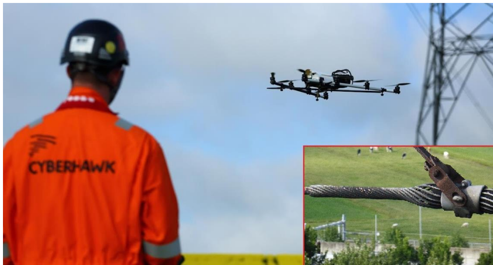
Sl.6. Kontrola dalekovoda bespilotnom letjelicom [12]
