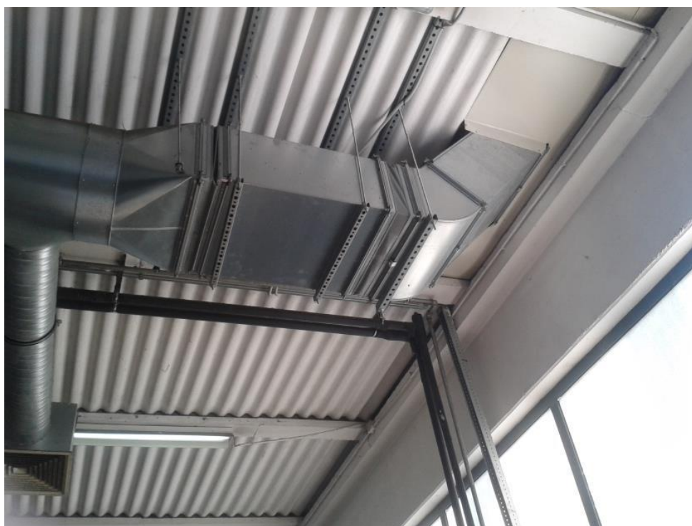
Slika 5.5. Apsorpcijski prigušivač zvuka
