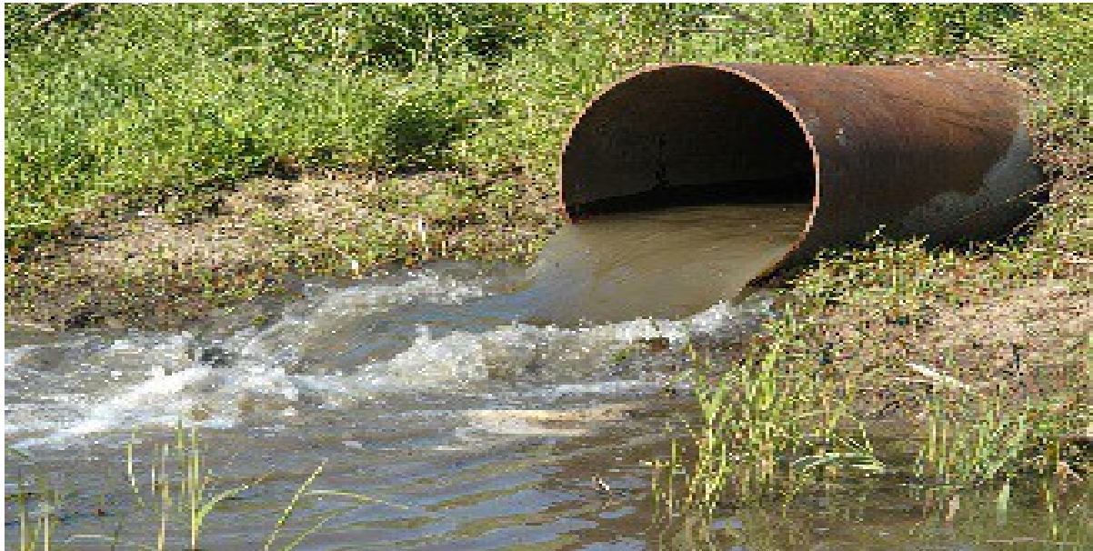
Slika 1. Prikaz neadekvatnih objekata za odvodnju otpadnih voda [2].
