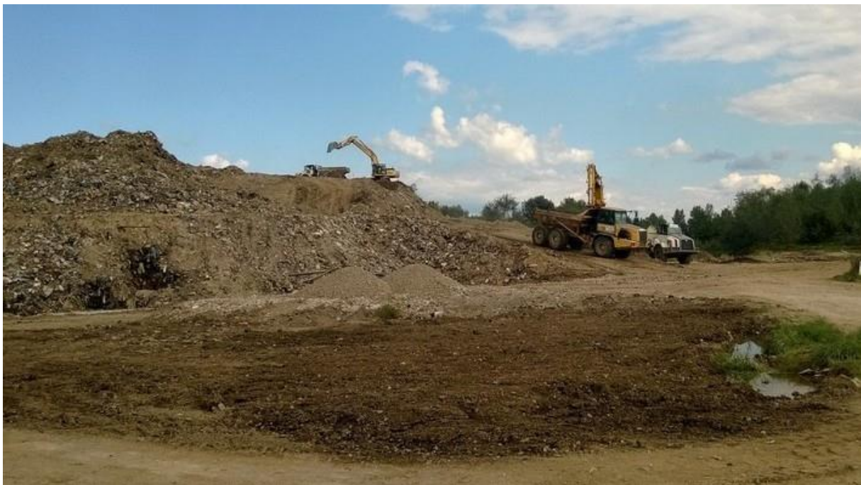
Slika17.Sanacija odlagališta otpada Trebež u Samoboru
