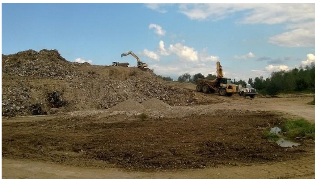
Slika17.Sanacija odlagališta otpada Trebež u Samoboru
