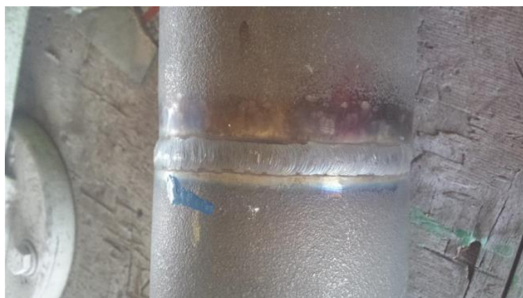
Slika 10. Pregled zavarenog spoja Vizualnom kontrolom [11]
