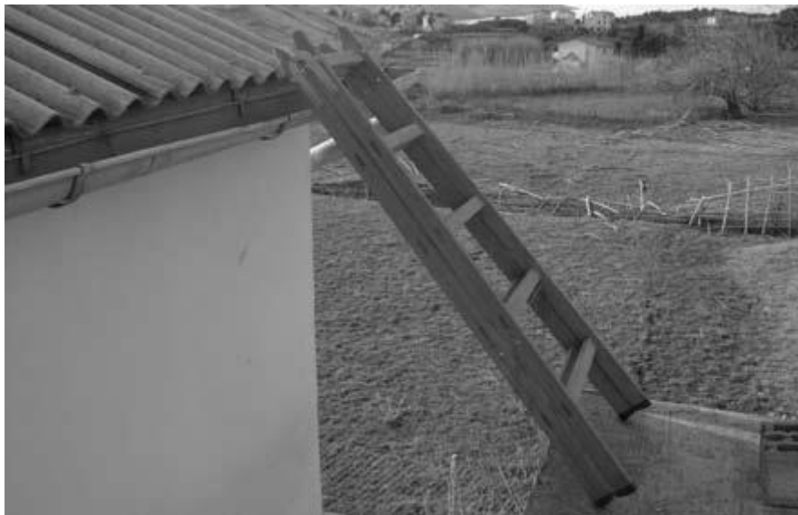
Slika 34 Prikaz krivo postavljenih ljestvi za rad [Čižmar, Đ. (2010). SMRTNA OZLJEDA RADNIKA NA PRIVREMENOM GRADILIŠTU. Sigurnost : časopis za sigurnost u radnoj i životnoj okolini, 52(2), 169-171. Preuzeto s http://hrcak.srce.hr/70254 ]
