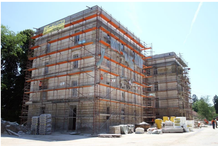
Slika 8 Prikaz postavljenih skela na gradilištu
