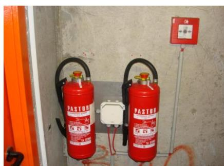
Slika 6 - SOS niša sa aparatima za gašenje požara, adresabilnim modulom i ručnim javljačem požara [4]
