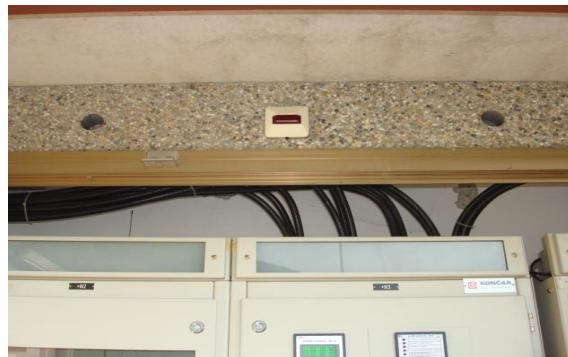
Slika 10 - Indikator prorade javljača iznad vrata trafostanice [4]
