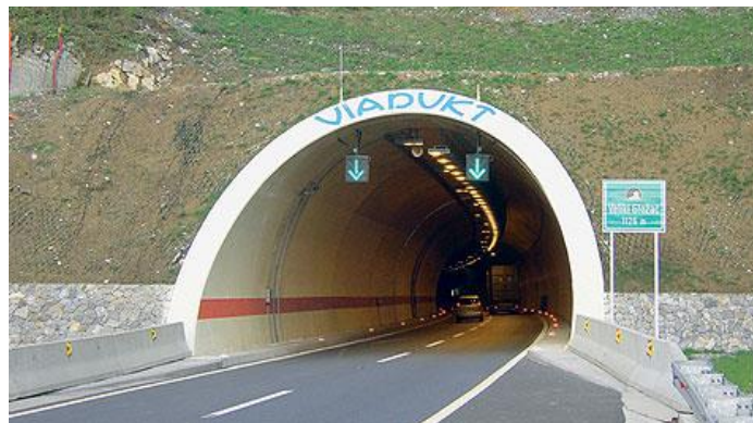
Slika 1: Tunel Veliki Gložac (južna cijev) [3]
