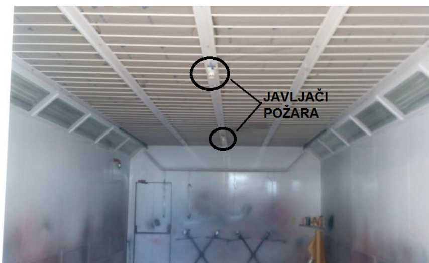
Sl. 44. Prikaz položaja javljača požara u komori za lakiranje
