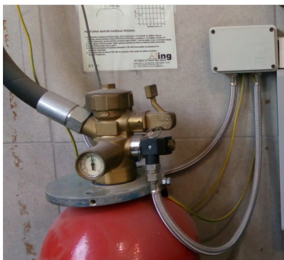
Sl. 39. Prikaz ventila na spremniku plina FM-200
