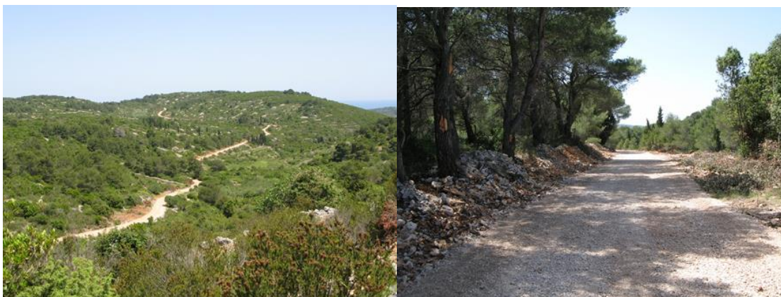
Slika 26. I slika 27. Protupožarna prosjeka s elementima šumske ceste
