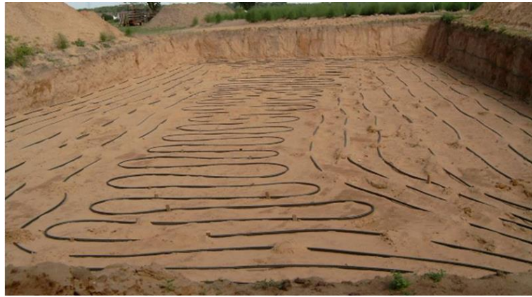
Slika 16. Vodorravno kolektorsko polje sa serijskim povezanim cijevima [4]
