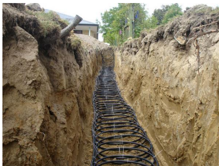
Slika 17. Spiralni kanalni kolektor u jarku [4]
