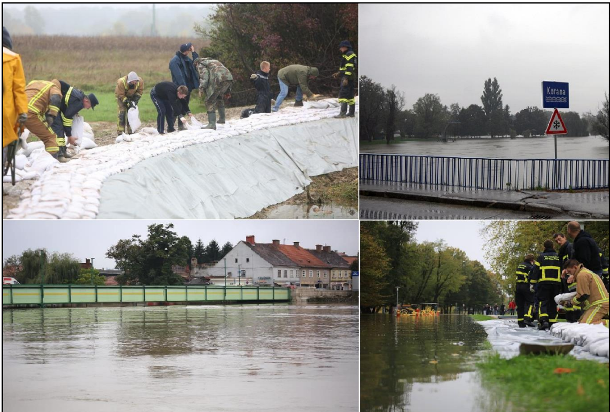
Sl. 20. Gradnja zečjih nasipa [18]
