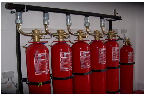
Slika 11. Sistemi za gašenje plinom Novec 1230
