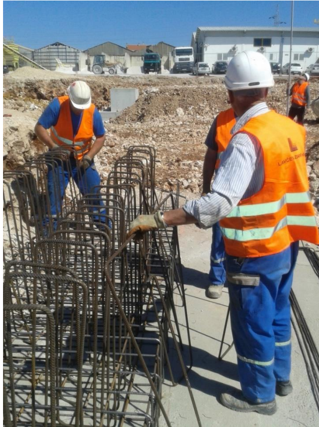
Sl. 8. Postavljanje armature
