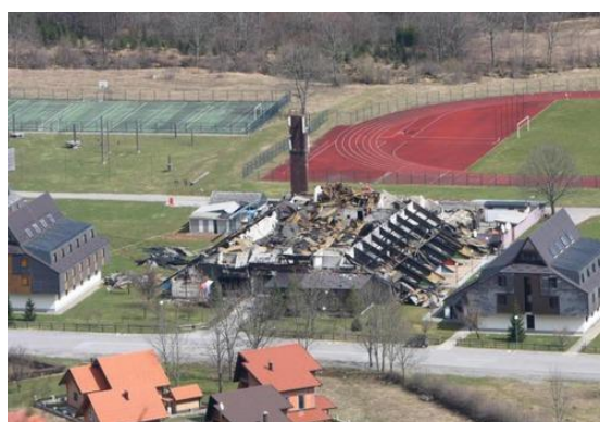
Sl.14. Kotlovnica i dimnjak [15]
