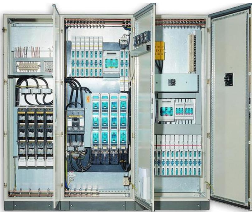
**Slika 9.** Ugradnjom razvodnih ormarića postiže se zaštita od izravnoga dodira [10].
