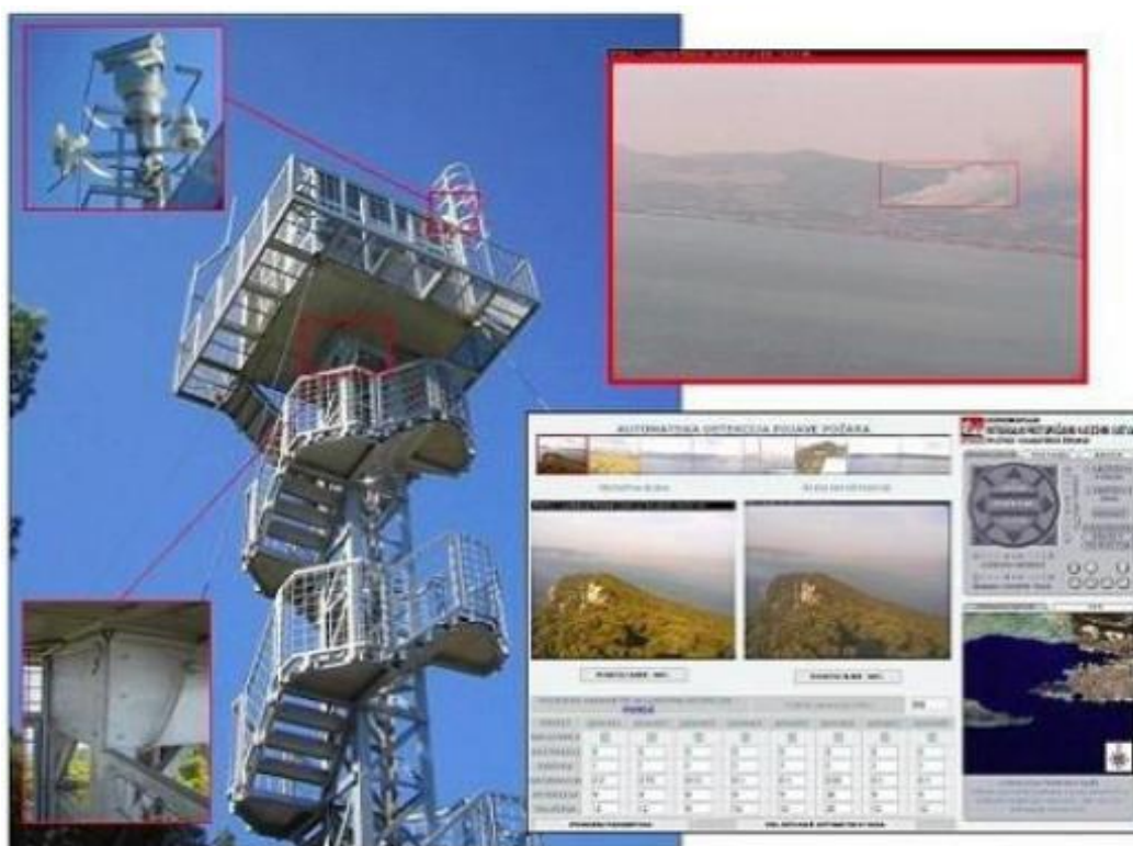
Sl. 8. Motrilačka jedinica i korisničko sučelje sustava IPNAS [9]
