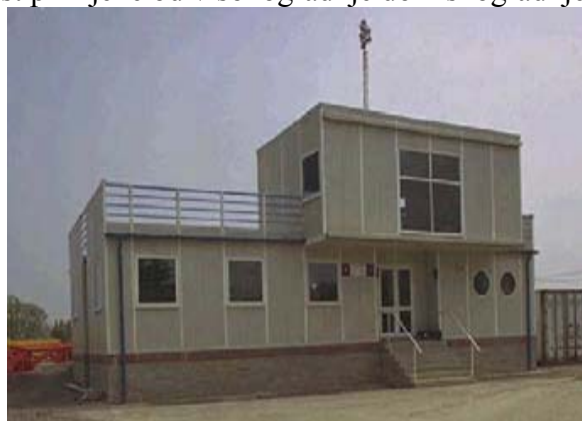
Slika 6.: Prikaz primjene kompozita u građevinarstvu [4]
