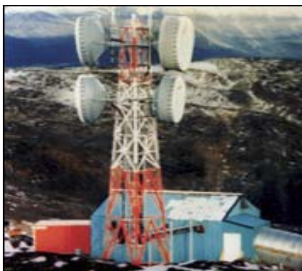
Slika 5.: Prikaz primjene kompozita u građevinarstvu [4]
