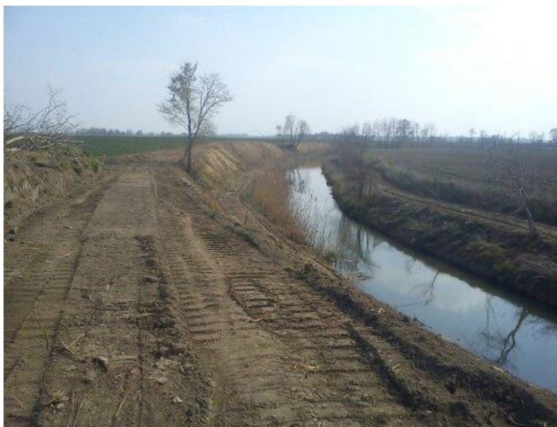
Slika 2. Radovi na uređenju korita Karašice, u travnju 2014. (Foto: I. Mandić )
