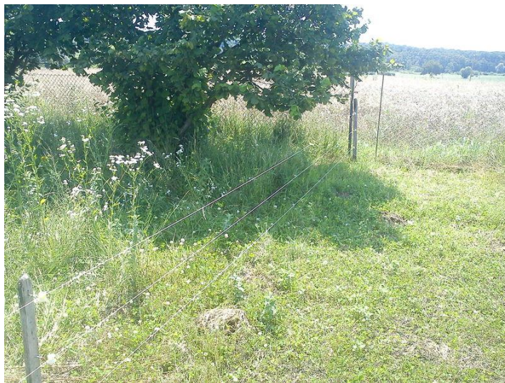
Slika 13. Postavljanje električne ograde
