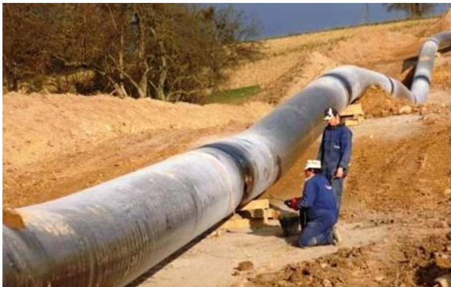
Slika 6. - Zavarivanje magistralnog plinovoda
