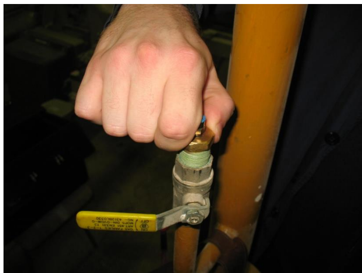
Slika 19. - Pritezanje priključka rukom
