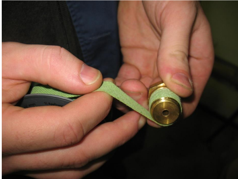
Slika 18. - Namatanje teflonske trake za brtvljenje na priključak
