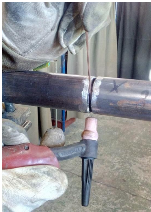
Slika 38. Namještanje elektrode i dodatnog materijala
