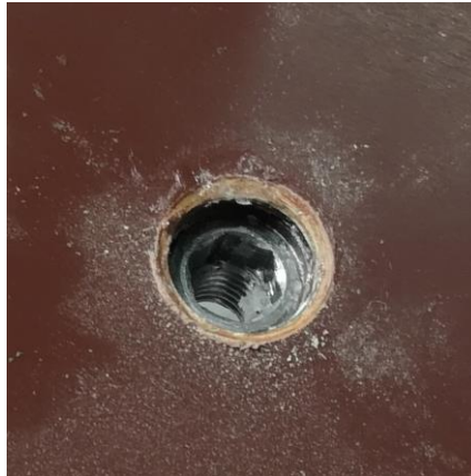
Slika 70. Trio matica u svojoj konačnoj poziciji
