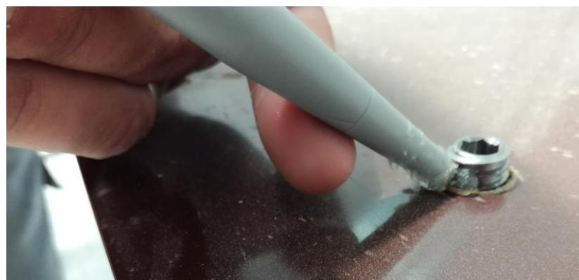
**Slika 69. Silikoniranje vanjskog navoja trio matice**
