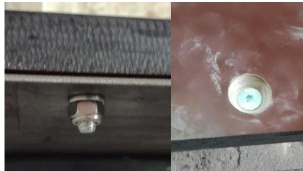
Slika 83. Stegnute ploče odozdo (lijevo) i odozgo (desno)
