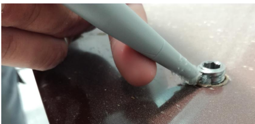
Slika 69. Silikoniranje vanjskog navoja trio matice
