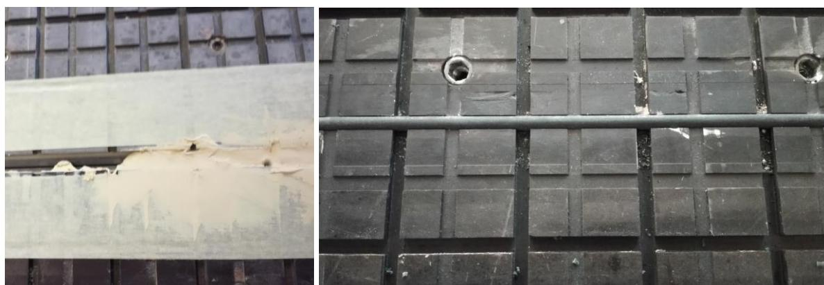
Slika 142. Popravak oštećenja (lijevo), preglodano i obojano (desno)
