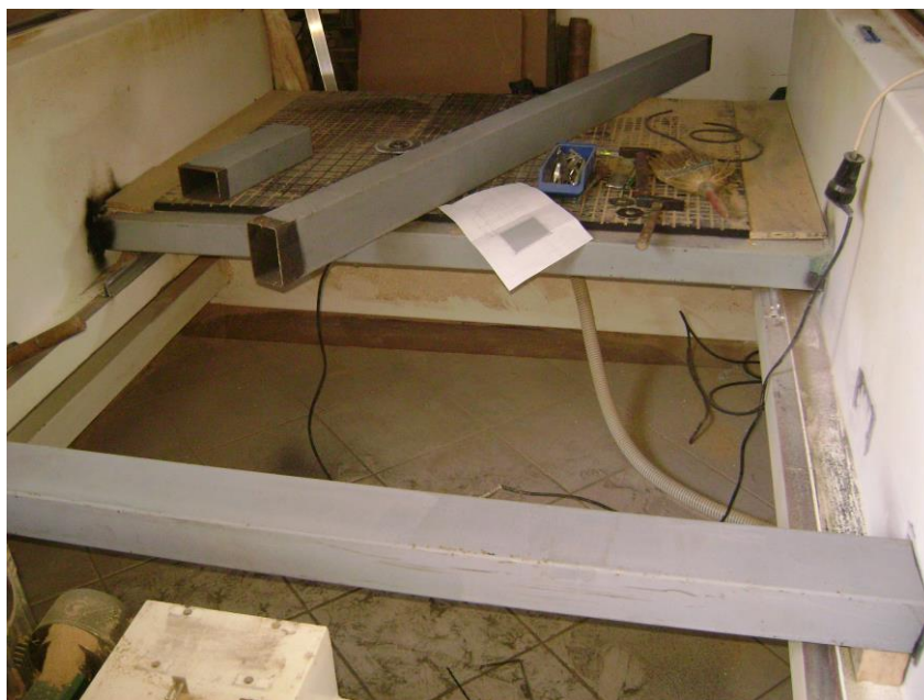
Slika 91. Proces zavarivanja dodatnih cijevi
