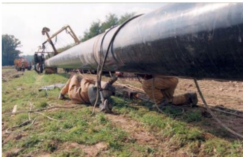
Slika 35. Zavarivanje cjevovoda celulozno obloženom elektrodom [21]
