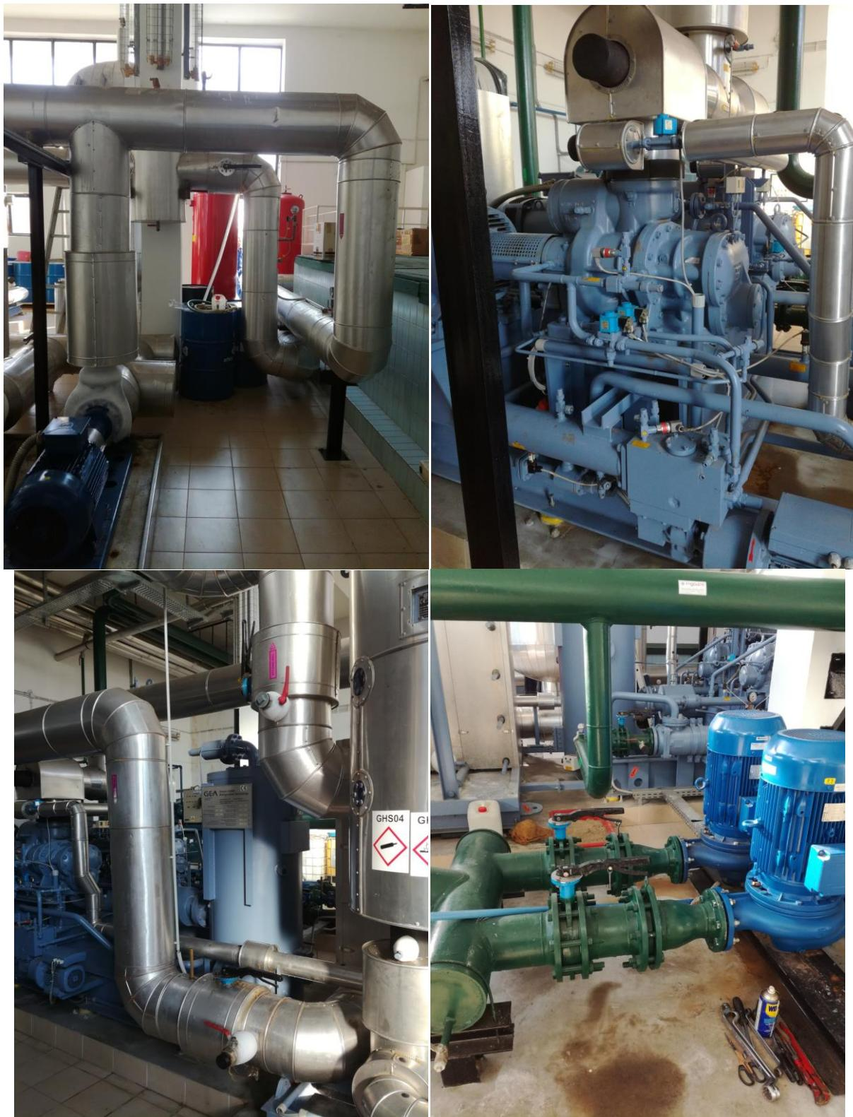
Potrebna rashladna snaga za ovakav tip klizališta s vremenom zaleđivanja površine 8h do debljine 1/2" iznosi oko 670 kW.
