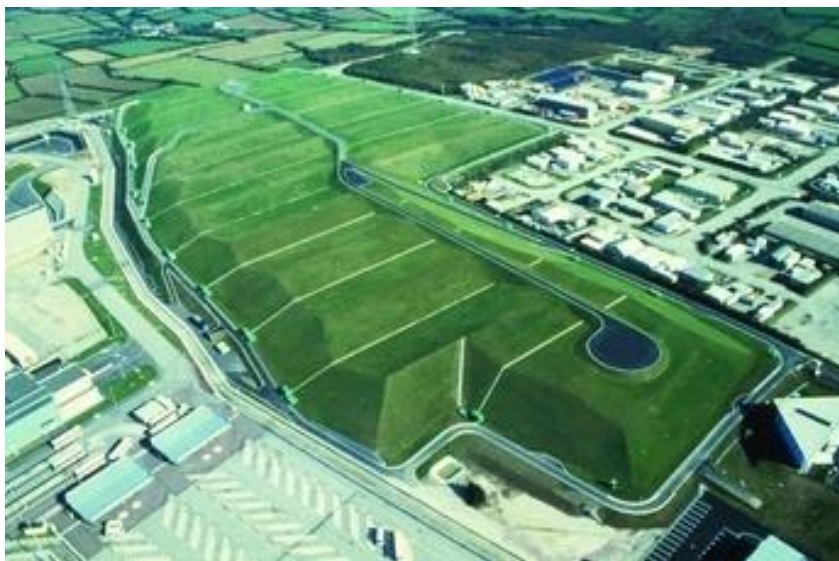
Sl. 19 Površinsko odlagalište „Centre de la Manche“ u Francuskoj
