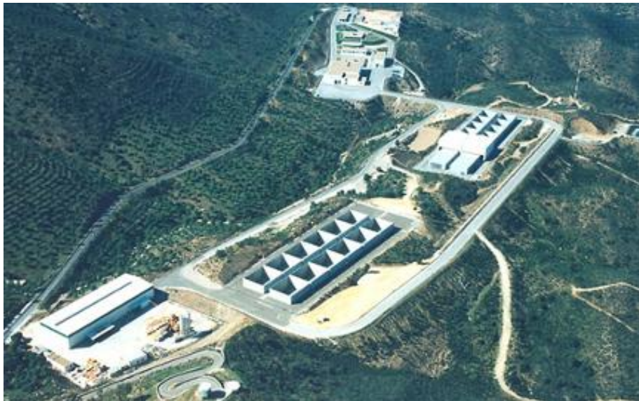
Sl. 17 Površinsko odlagalište u El Cabrilu, Španjolska
