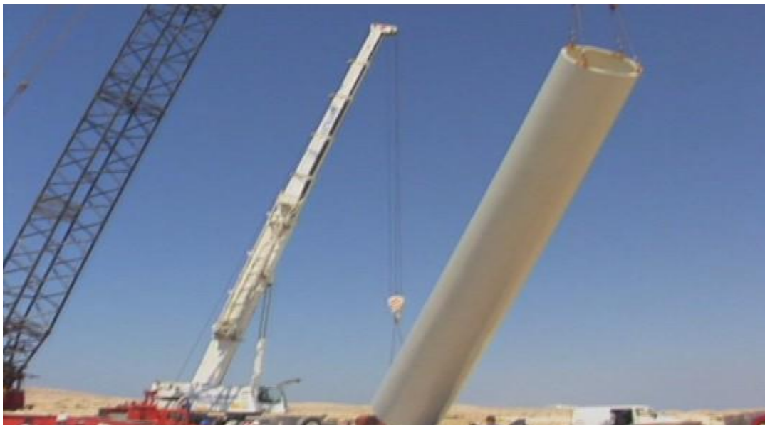
Slika 18. Kran podiže i postavlja stup na već izrađeni temelj
