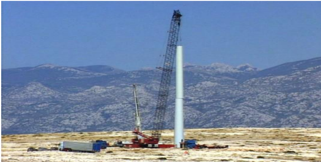
Slika 19. Slaganje stupa
