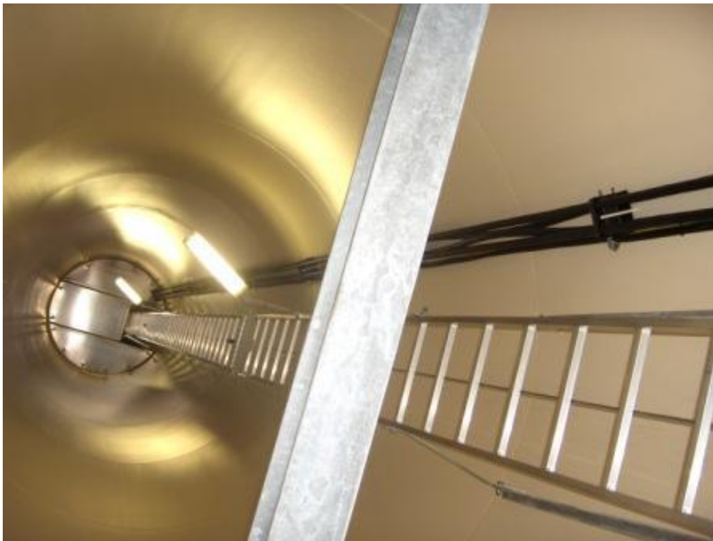
Slika 14. Unutrašnjost stupa vjetrogeneratora
