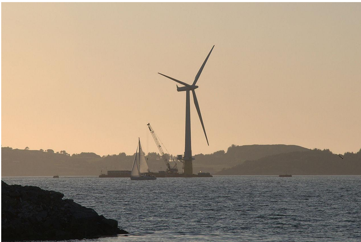
Slika 24. Prvi veći plutajući vjetroagregat Hywind, koji je sklopljen u Stavangeru (Norveška), prije nego je postavljen u Sjevernom moru.
