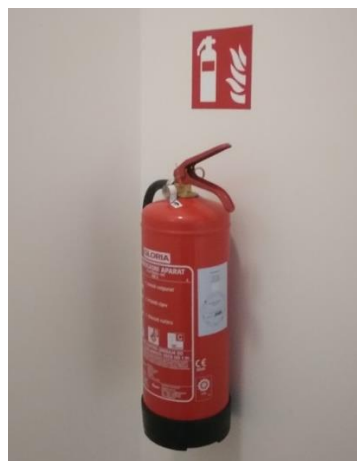
Slika 10. Pravilno postavljen i označen pp aparat [10]
