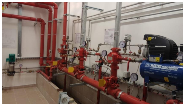
Slika 23. Sprinkler stanica-kombinirani mokri i suhi sustav [10]
