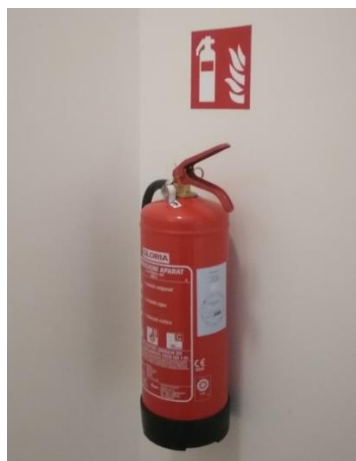
Slika 10. Pravilno postavljen i označen pp aparat [10]
