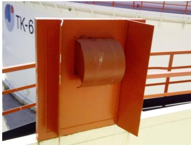
Sl. 25. Zračna komora za tešku pjenu [vlastita fotografija]
