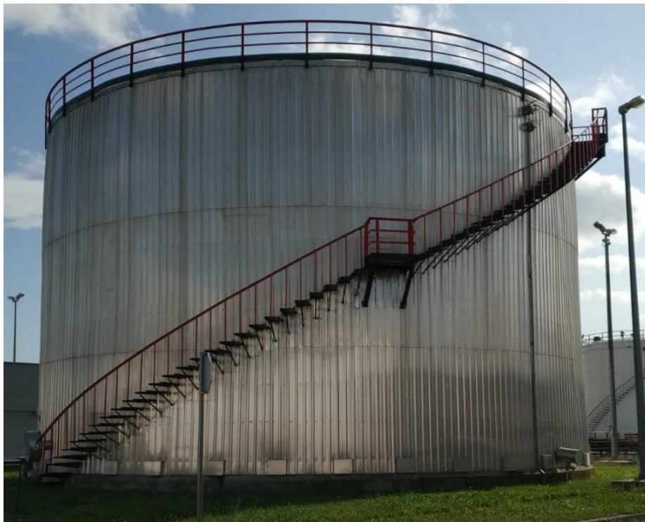
Sl. 21. Nadzemni spremnik vode [vlastita fotografija]
