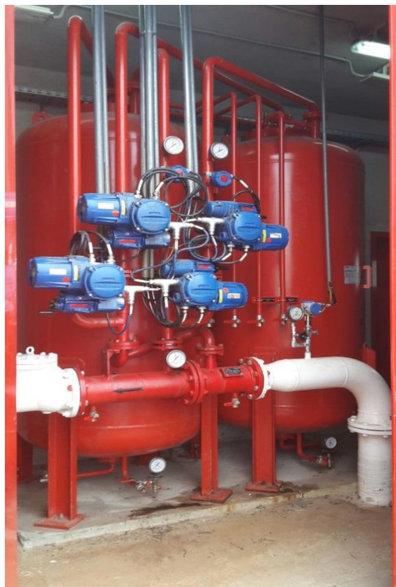
Sl. 24. Jedinica za pripremu pjene [vlastita fotografija]
