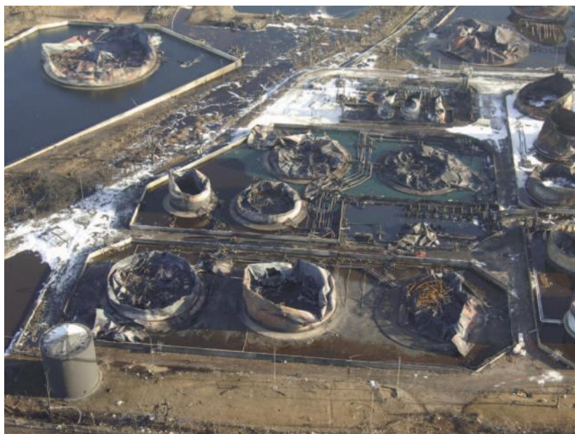
Sl. 19. Ostaci terminala nakon požara [9]
