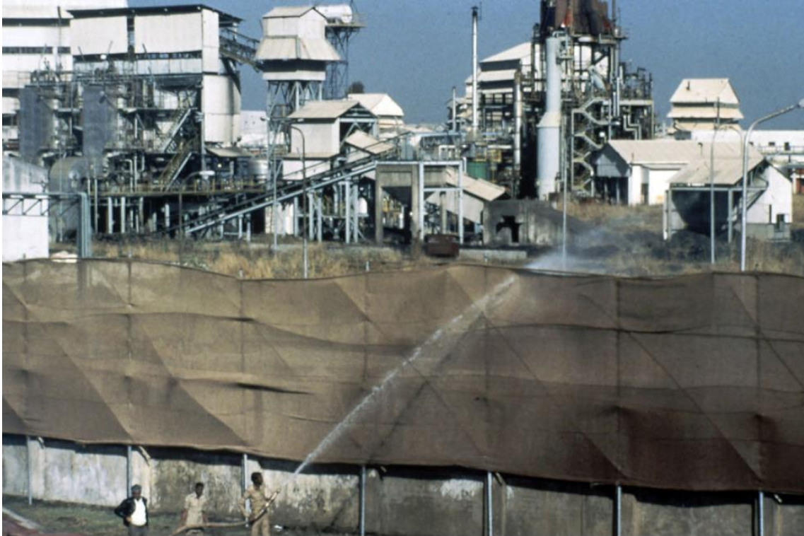
Slika. 32. Postavljanje mokrog platna oko postrojenja
