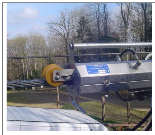
Podmazivanje čeličnog užeta
