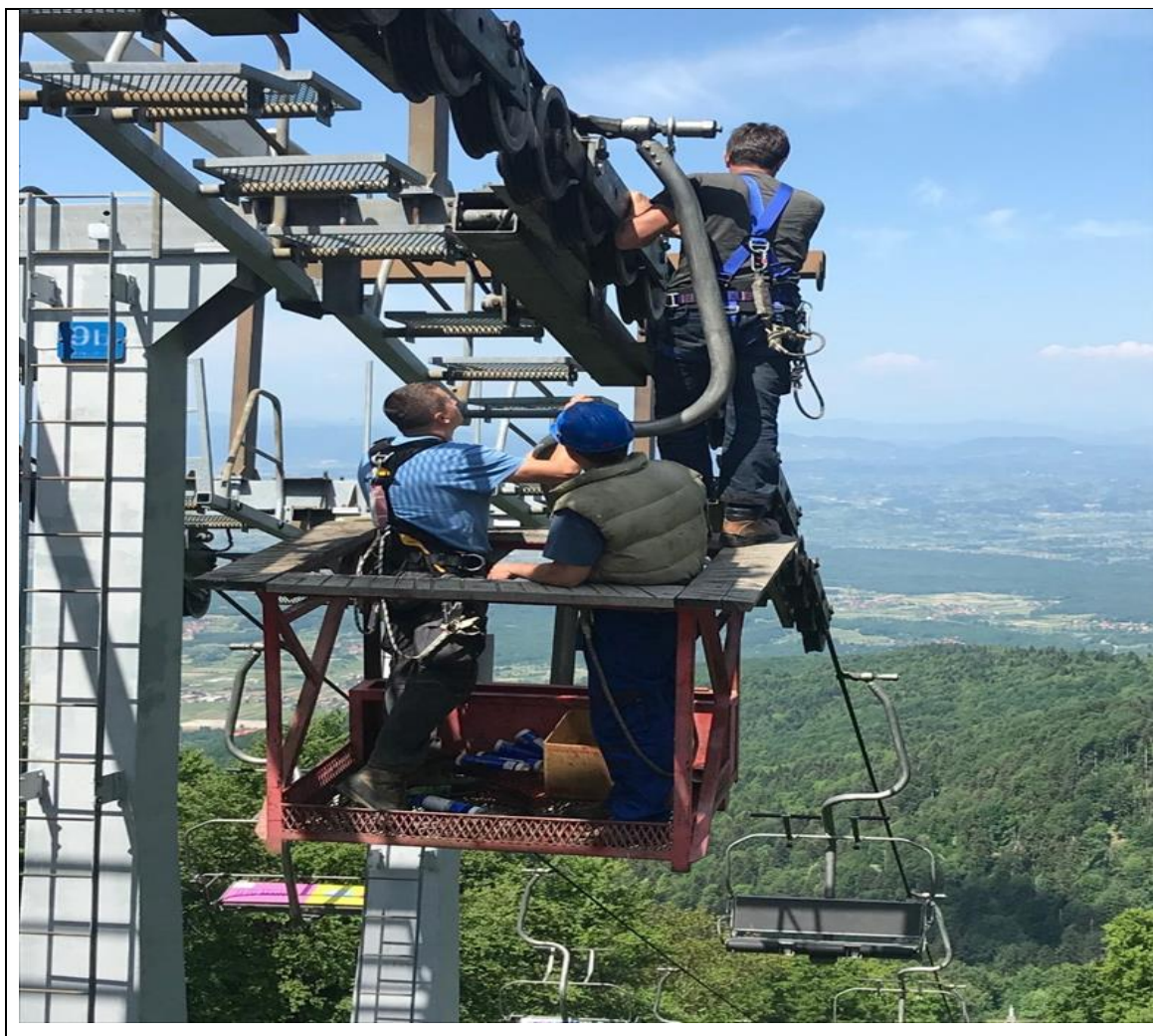
Slika 8. Podmazivanje baterijskih sklopova
