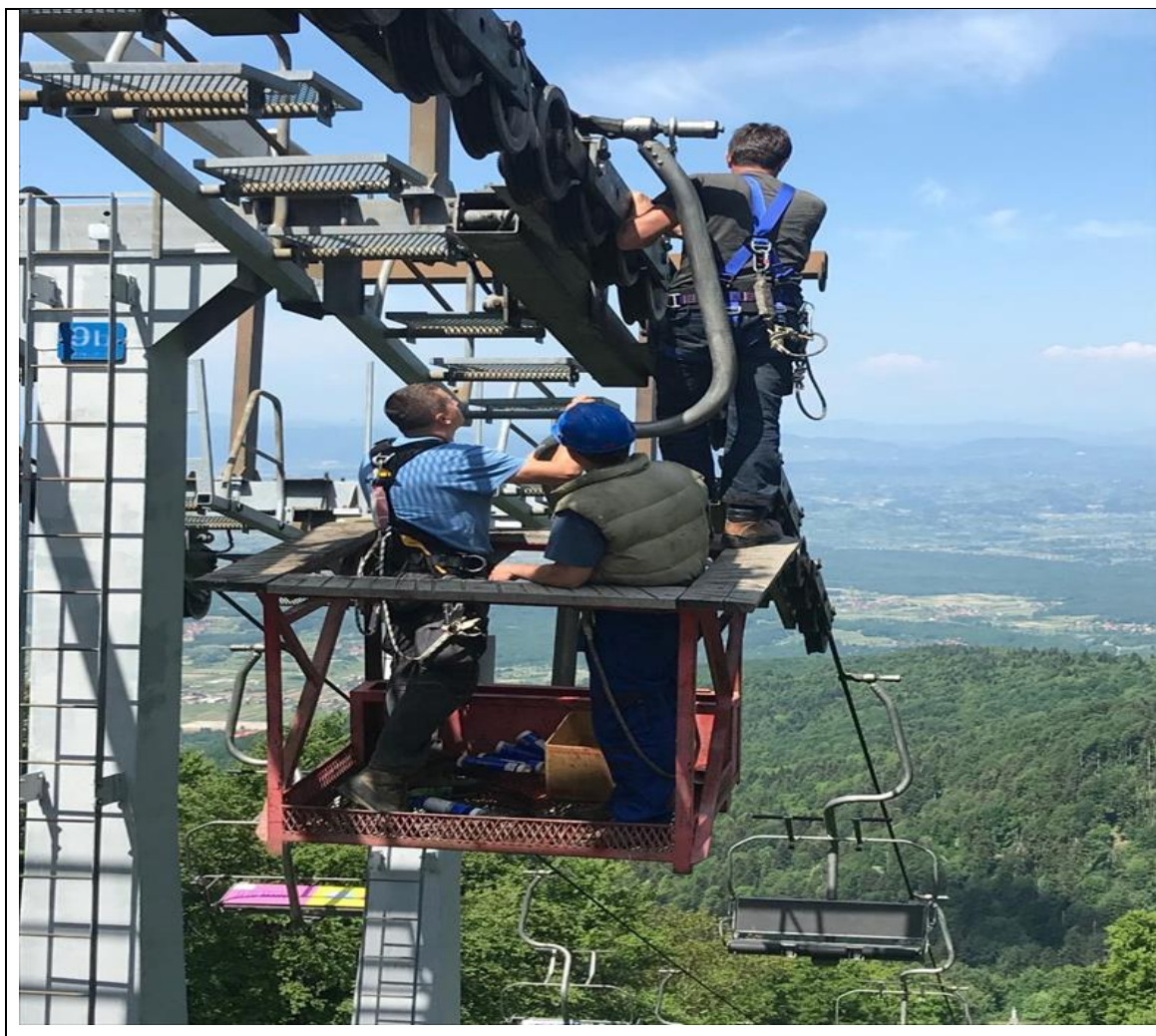
Slika 8. Podmazivanje baterijskih sklopova
