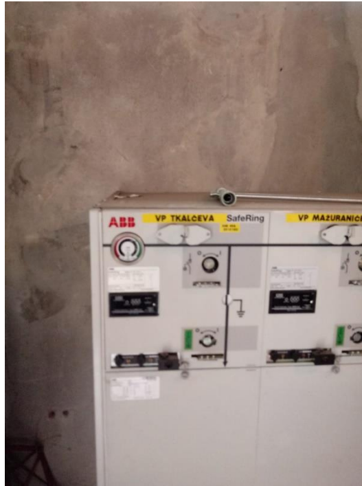
Slika 29. Predodžba ABB bloka s daljinskim upravljanjem.
