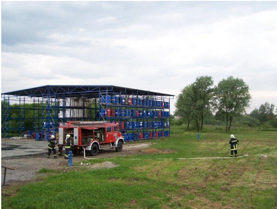
Slika 31. Industrijska zgrada „C“ sa nadzemnim hidrantima broj 1 i 2 [20]
