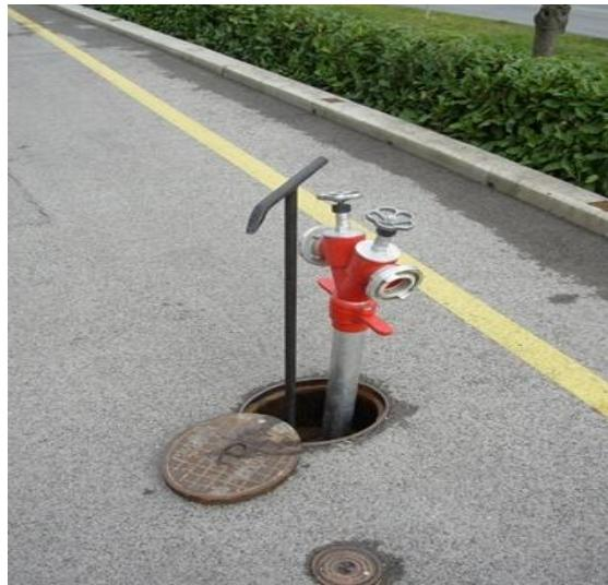
Slika 24. Hidrantski nastavak spojen na podzemni hidrant [18]
