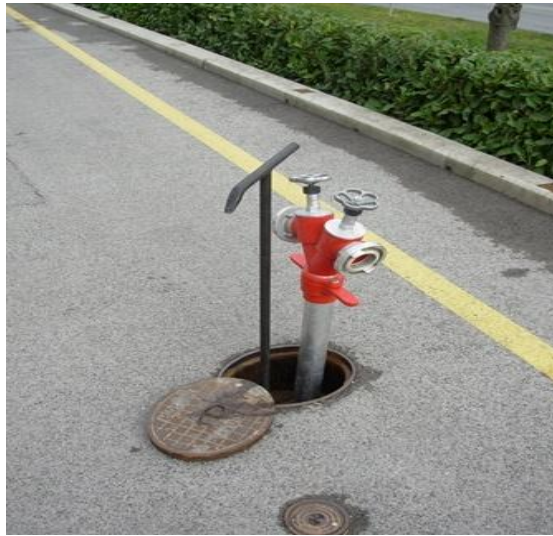
Slika 24. Hidrantski nastavak spojen na podzemni hidrant [18]
