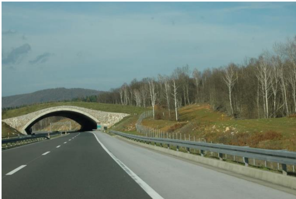
Slika br. 2 Zeleni most Ivačeno brdo izgrađen na autocesti A1
