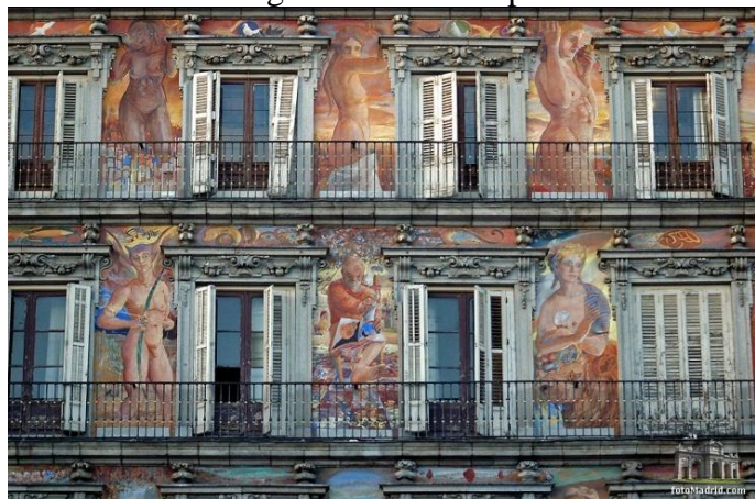
Slika 28. Fasada zgrade Casa de la panaderia
